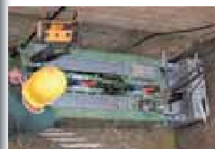
Bild unten: Rohrerneuerung mit GRUNDOBURST
